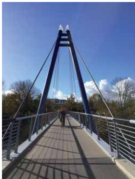
Die Brücke am Pappelstieg war erst der Anfang. Bald werden alle Gera-Brücken zwischen Karlstraße und Gispersleben erneuert
